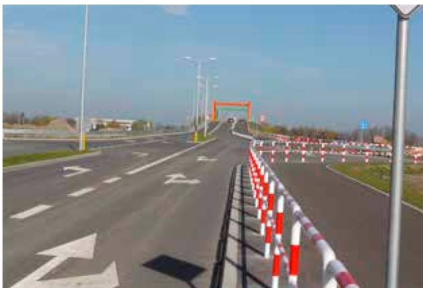
Nowy wiadukt nad torami kolejowymi w Jasinie – widok od strony ul. Rabowickiej.
