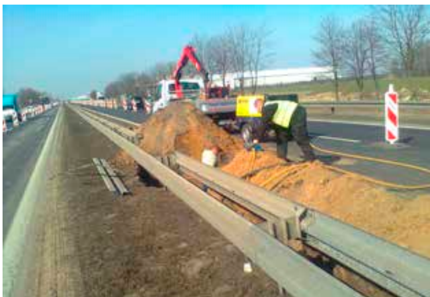
Na drodze krajowej nr 92 w Jasinie – początek budowy skrzyżowania, które połączy ją z nowym wiaduktem nad torami kolejowymi i przebudowaną ul. Rabowicką.
