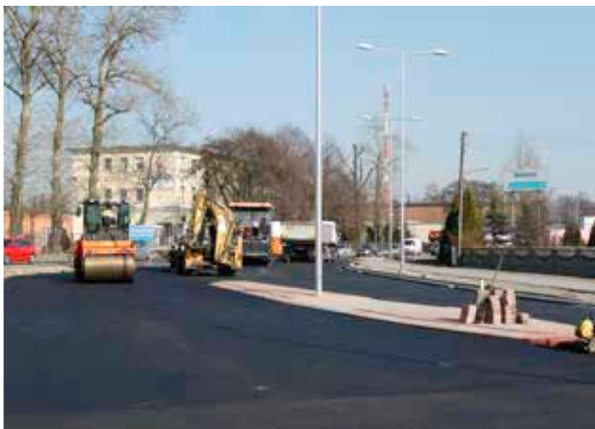
Przebudowa ul. Średzkiej – ostatnie prace na nowym skrzyżowaniu z ul. Rabowicką.
