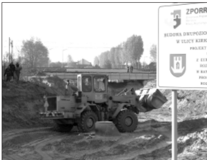
W końcu kwietnia na budowie dwupoziomowego skrzyżowania w ul. Kirkora.
