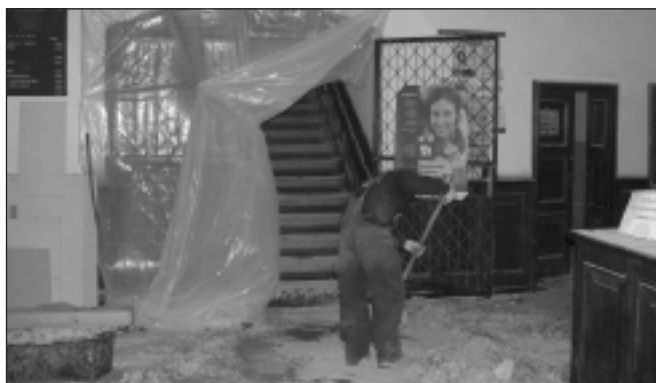
Podczas przebudowy holu ratusza.
