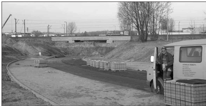
17 stycznia na budowie nowej ul. Kirkora.
