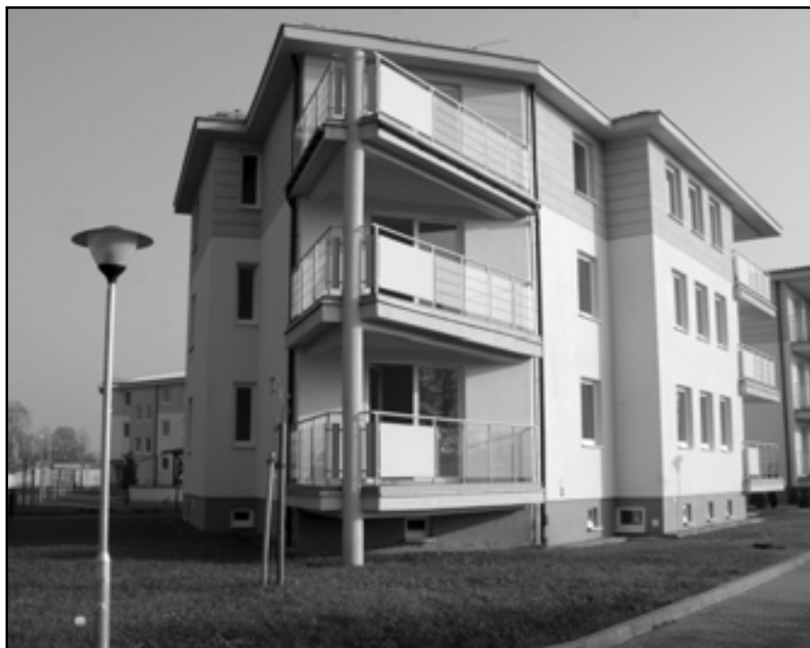
Przy ul. Kaczorowskiego wybudowano 45 mieszkań komunalnych.
