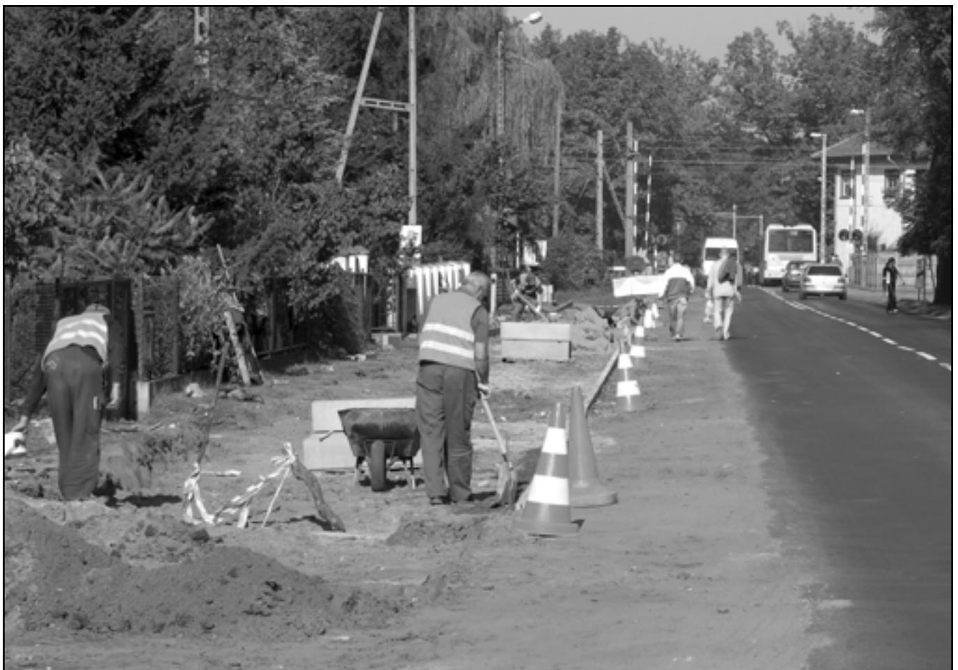
Budowa chodnika w Kobylnicy.
