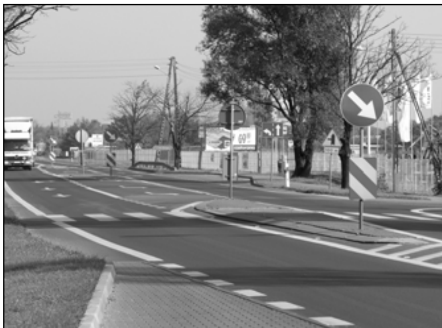
Na drodze nr 5 w Janikowie i Kobylnicy utworzone zostały wysepki dla pieszych. Gmina założyła tam oświetlenie, aby było bezpieczniejsze.
