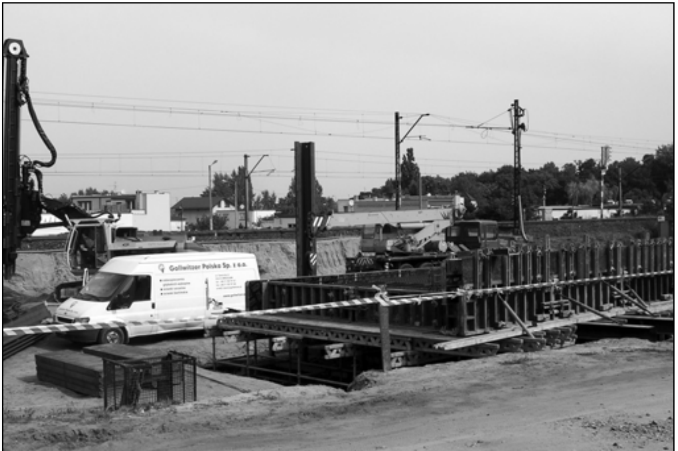
Latem rozpoczęła się budowa tunelu pod torami.
