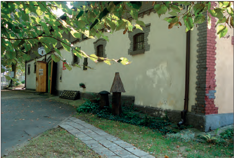
Widok na dawną stajnię, obecnie budynek Muzeum Pszczelarstwa oraz Owadów Użytkowych. Fot. Jerzy Kamprowski
