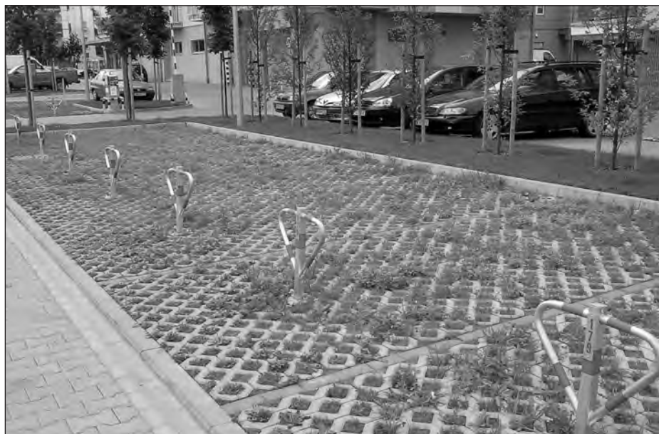
Parking pokryty powierzchnią przepuszczalną na os. Działyńskiego. Fot. Adam Choryński
