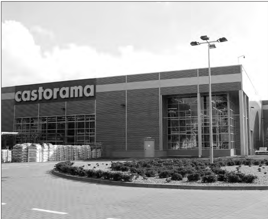
Hipermarket budowlany sieci Castorama, otwarty w sierpniu 2012 r., w którym znalazło zatrudnienie ok. 120 osób. Fot. Arkadiusz Małyszka
